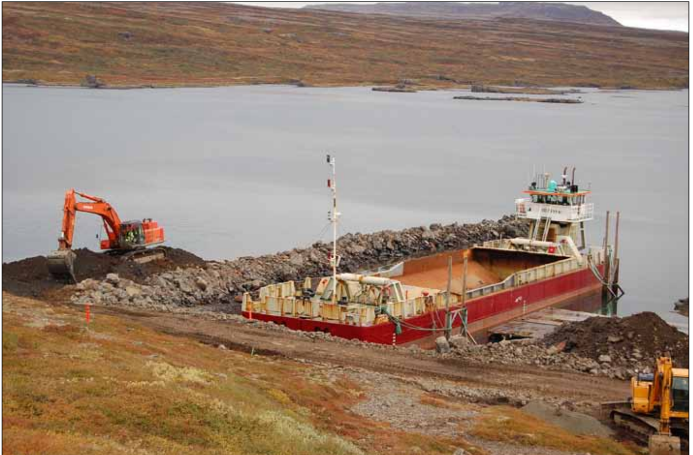
Vestfjarðavegur (60), Eiði - Þverá. Framkvæmdir í Mjóafirði. Verktaki er Suðurverk hf. Pramminn flytur efni í fyllinguna yfir fjörðinn. Hann tekur 400 m 3 fulllestaður en minna þegar lágsjávað er. Reiknað er með að hann muni fara 8 ferðir á dag. Sjá einnig mynd á baksíðu.
